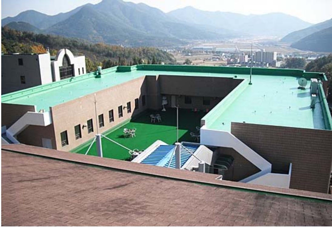
옥상방수 - 시공후 전경
