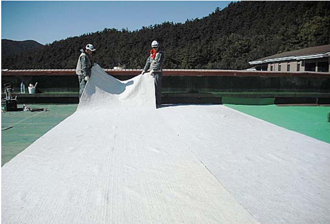
옥상방수 - 트라이슈머® 단열베이스카펫 시공
