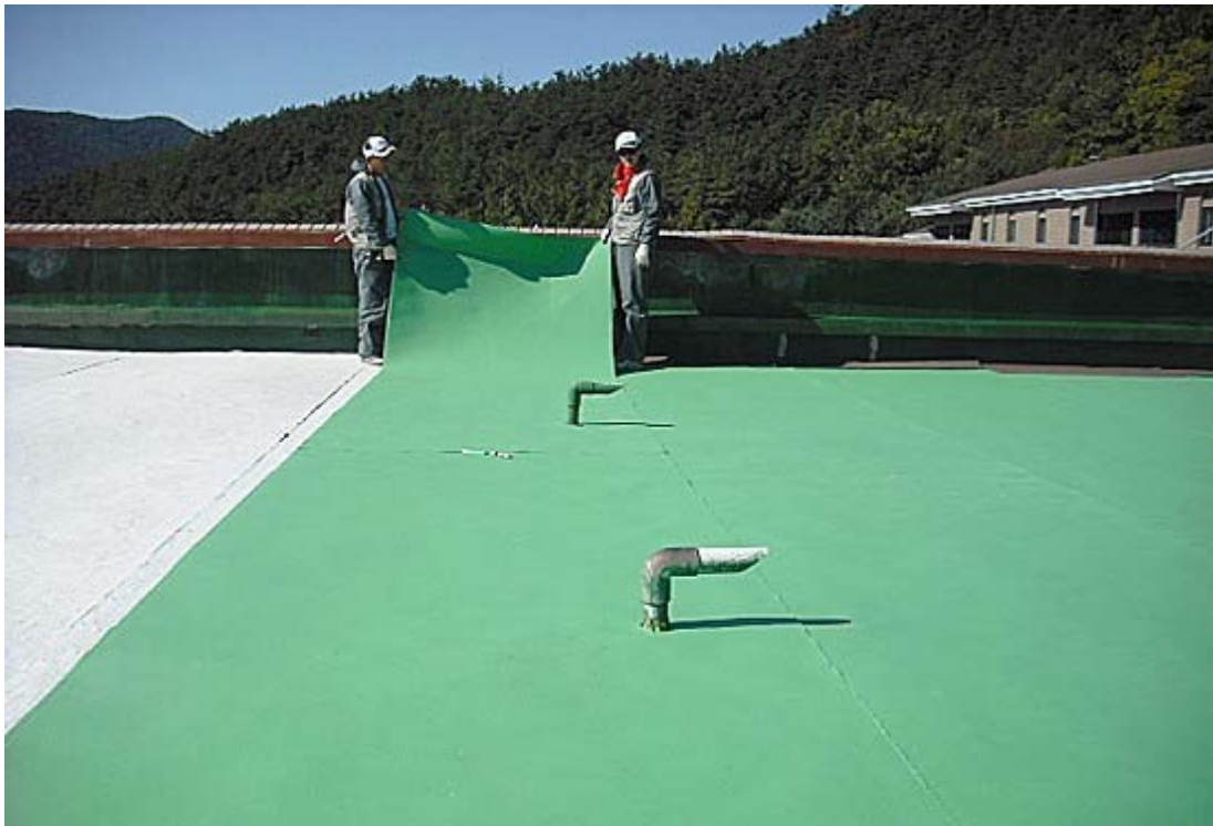
옥상방수 - 트라이슈머® 단열복합시트 시공
