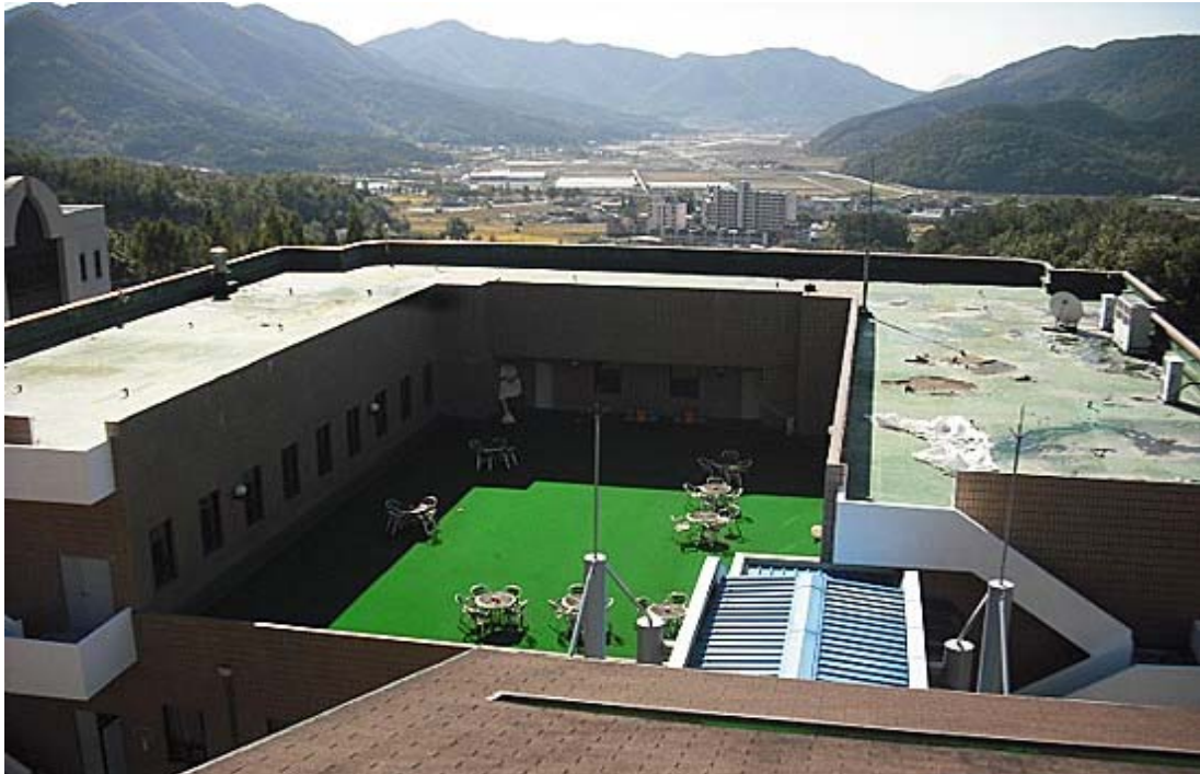
옥상방수 - 시공전 전경
